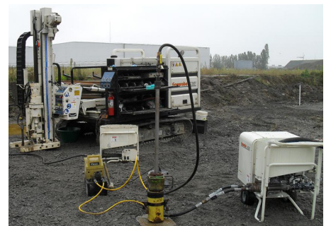
Injectie oxidantia op de site Carcoke Marly in Neder-Over-Heembeek
